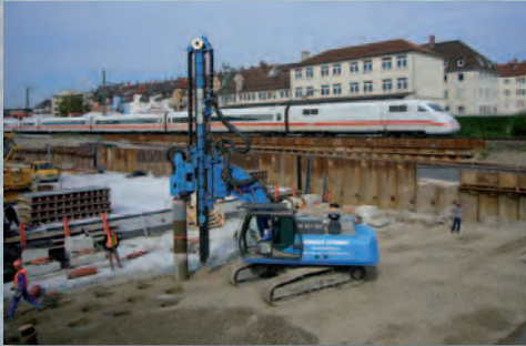
Tiefenverdichtung unter zukünftiger Troglplatte
