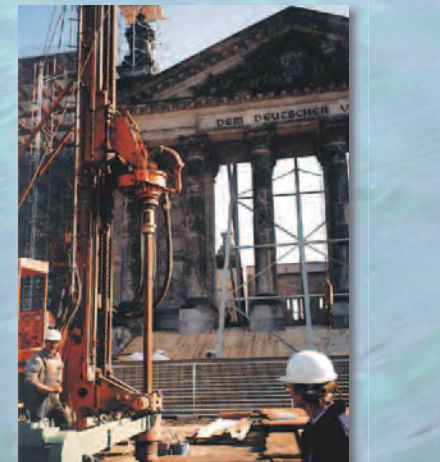
Brunnenbohrung vor dem Reichstagsgebäude
