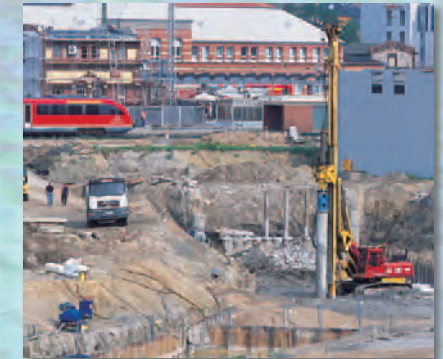
Straßenbahntunnel Hauptbahnhof Rostock
