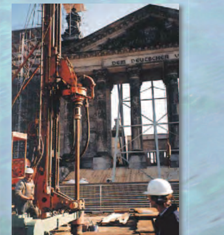
Brunnenbohrung vor dem Reichstagsgebäude
