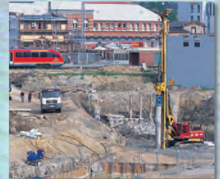
Straßenbahntunnel Hauptbahnhof Rostock
